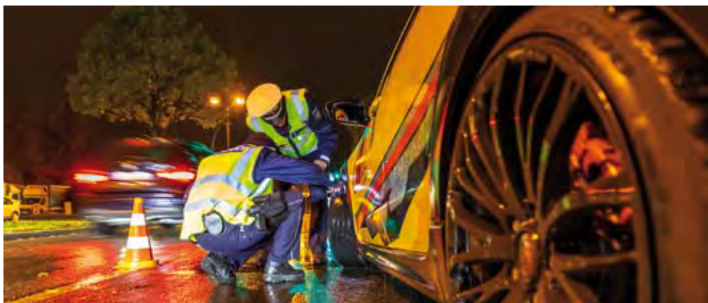
Pascal Weise untersucht den Radkasten auf Schleifspuren, um festzustellen, ob Kontakt zwischen Reifen und Karosserie besteht.
